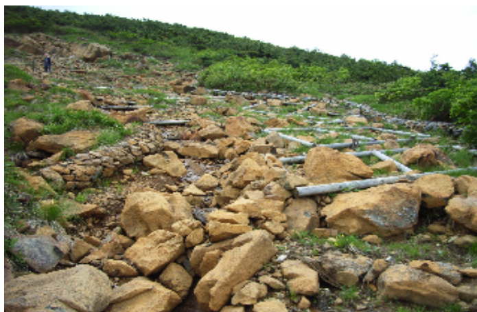
広範囲に深刻な荒廃が進む東面登山道（標高1800m付近）
