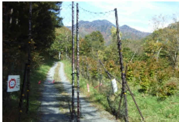
【大清水付近のシカ柵(高さ2.4m、長さ約5Km)】
