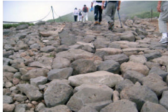
月山登山道の「いしだたみ」部分。降雨で流されないよう「割グリ」等で敷き詰めてある。
