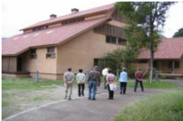
尾瀬高校自然環境棟。自然環境科の生徒たちは“純木造”のこの校舎で学んでいる。
