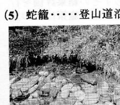
(5) 蛇籠……登山道沿い及び地点 5 に見られるが、概ね蛇籠と基盤土壤の間に隙間があって土壤浸食防止には役立っていない。蛇籠の目を小さくし、入れる礫も小さいもの、籠の直径も 10 ~ 20 cm 程度にし、配置方向を考慮に入れたら意味をなしてくるのではないか。更なる研究を望む。特に蛇籠と原生土壤との間にはノッチ部分 (窪み) ができやすいのでその原因を考察し、蛇籠そのものの工夫と設置方法を考える必要がある。又、写真 12 のごとくすでにノッチ部ができてしまっている場合にはその崩落防止のために蛇籠・原生土壤間に早急に土嚢を入れたり、一般道路側壁と同じように裏込め工事を実施する。ノッチ部分への登山テッキの突き入れも少数だが見られる。
