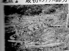
**地点 2～3** 丸太止めの石階段、両サイド丈の高い垣。道幅 2～2.5m、登山道に沿って一部蛇籠も見られ、両サイドからの土砂流失を防止している。又、登山道拡大防止用のロープもあるが一部用をなしていない部分も見られる。他に荒廃地放置気味の所、植生回復が見込まれる所あり。荒廃度 1～2
