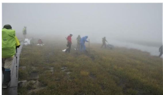
濃霧の中「ミズゴケ」を貼る作業 2019/9/21
